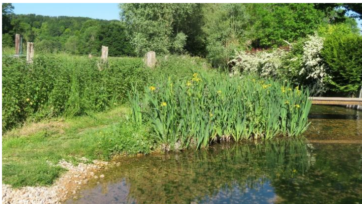
Franchissement du ruisseau du Mesnil
